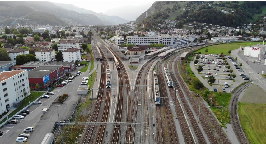
Verkehrsknotenpunkt Bahnhof Sargans
